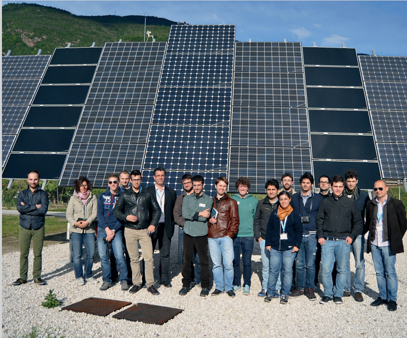
Studentengruppe vor der Photovoltaik- versuchsanlage am Bozner Flughafen: Innovationsstandort Südtirol
