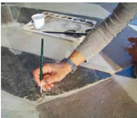
Lasierung der Fliesen des Fußbodens
