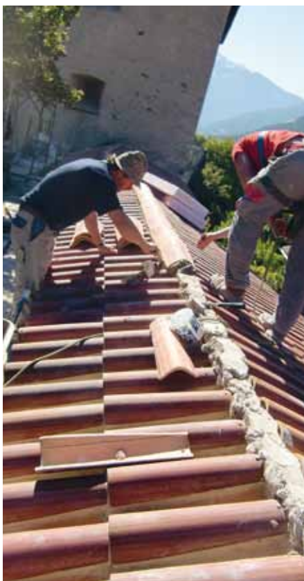
Sanierungsarbeiten an der Ringmauer von Glurns
