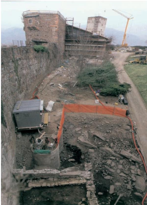
Ruine Sigmundskron: Grabungsareal neben dem Haupteingang
