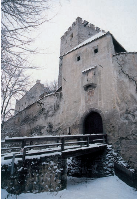
Der Torturm an der Ostseite des Schlosses und die Brücke, die ehemals eine Zugbrücke war und über den Schlossgraben führte
