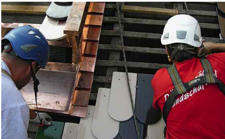
136.000 Biberschwanz- ziegel zieren das Dach des Bozner Domes.
