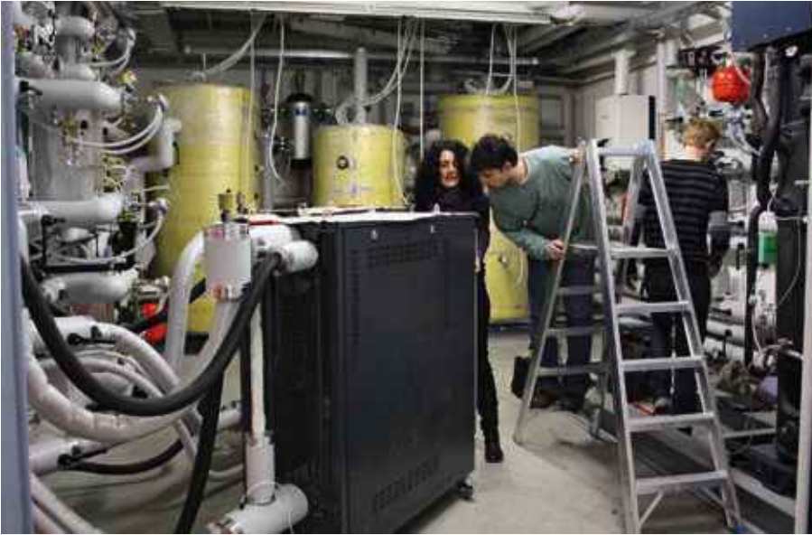
Institut für erneuerbare Energie: Grundlagenforschung in Bozen
