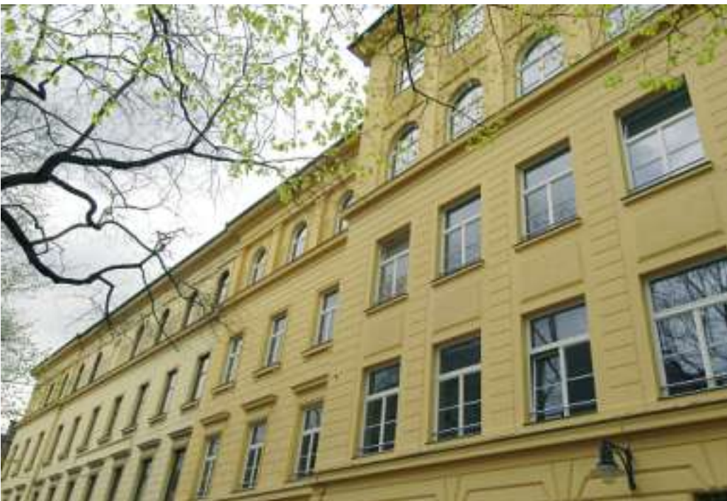
Das Franziskanergymnasium Bozen wurde behindertengerecht ausgestattet. Die von der Stiftung Südtiroler Sparkasse finanzierten Arbeiten umfassten unter anderem den Umbau von Aufzügen und sanitären Anlagen sowie die Errichtung von Rampen für Rollstuhlfahrer.
